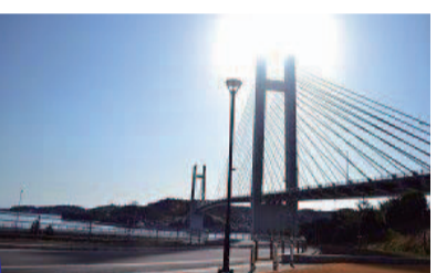
記念公園から見上げる生名橋 生名島:平成23年2月に完成した生名島と佐島に架かる生名橋。全長515m、コンクリート製の橋は、平成23年土木学会田中賞を受賞。
