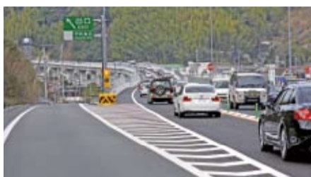
開通当日の宇和島北ICは通行車両で溢れた
